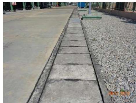
ภาพที่ 2.2-9 รางระบายน้ำฝนไม่ปนเปื้อน
