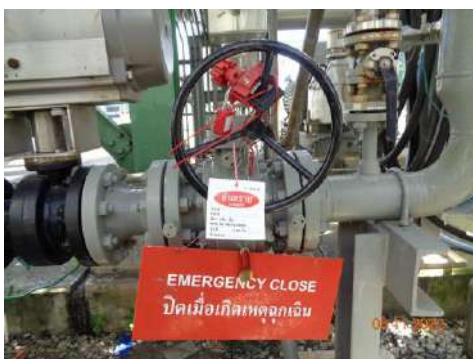
ภาพที่ 2.2-41 ป้ายปิดใส่กุญแจแล้ว สวิตช์ และติดป้าย (Lock Out-Tang OUR) บริเวณพื้นที่อับอากาศ
