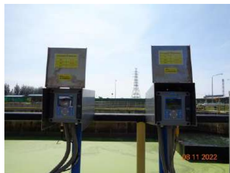
ภาพที่ 2.2-15 ระบบตรวจวัดน้ำทิ้งแบบอัตโนมัติ
