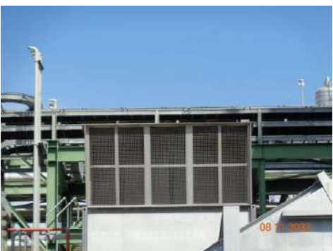
ภาพที่ 2.2-39 ระบบระบายความร้อนในท้องถิ่นกังหันก๊าซ
