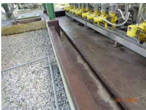
ภาพที่ 2.2-10 รางระบายน้ำฝนที่อาจปนเปื้อน
